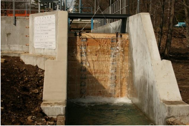
写真 5 越流堰の角落し
