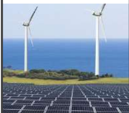
太陽光パネル 風力発電点検
