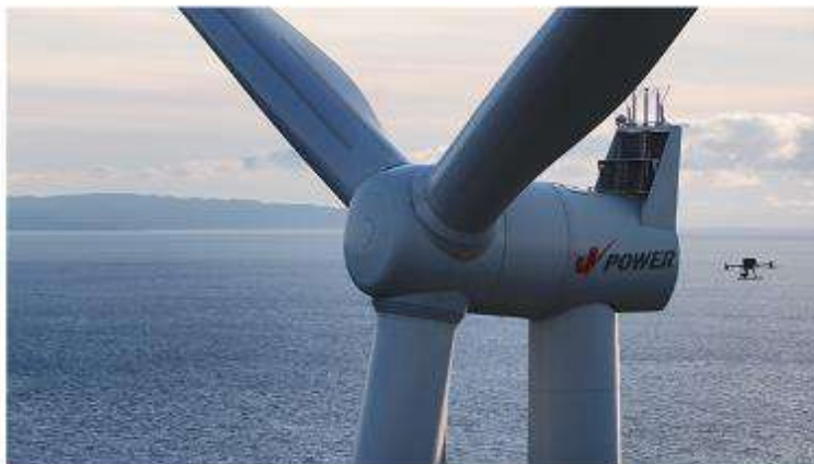
<本点検の様子>
