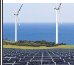
太陽光パネル 風力発電点検
