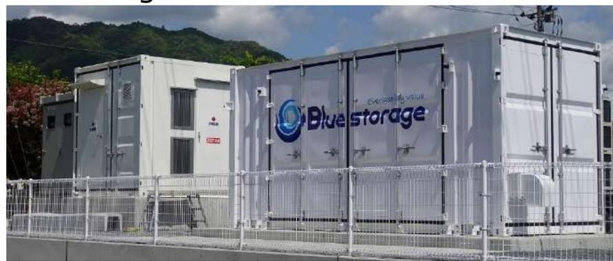
21年6月から初号機稼働開始(20ftで約1MWhの蓄電容量)
